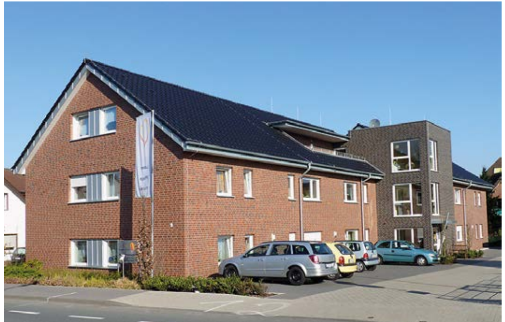
Die Pflegewohnungsgemeinschaft an der Westerwieher Straße stellt sich auf die Bedürfnisse der Bewohner ein und möchte ihnen die Chance geben, den Zimmern eine eigene Lebensgeschichte zu geben. Fotos: privat
