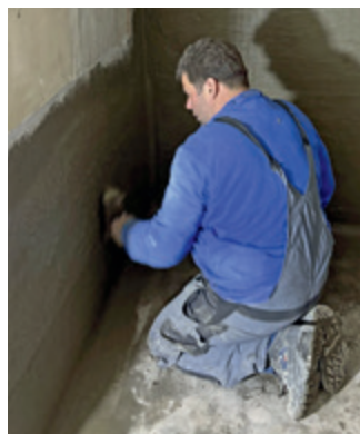
Mitarbeiter Carsten Schneider dichtet eine Wand mit spezieller Dichtungsschlämme ab.
