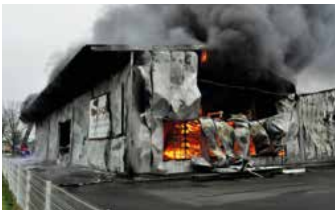
Extremste Hitze lies Metallverkleidungen der Hallen wie Butter wegschmelzen.
