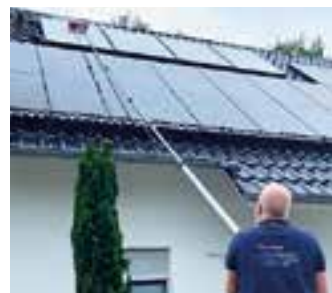
Reinigung mit Carbon-Teleskopstange.
