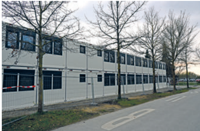
Die zweigeschossigen Wohncontainer an der Markenstraße sollen im Mai bezugsfertig sein. Foto: RSA/Pfaff
